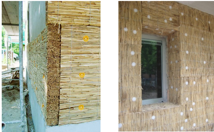
Figure 8. Hiss Reet Aussendämmung (HISS REET GmbH, 2011a) and Figure 9. Leo Bodner Schilfrohrplatte (Bodner, 2023)
