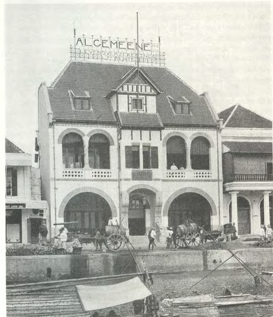
Fig. 2b. H.P. Berlage, building for 'De Algemeene', Surabaya, 1900 (Source: Het Nieuwe Instituut [HNI], Photo Collection).
