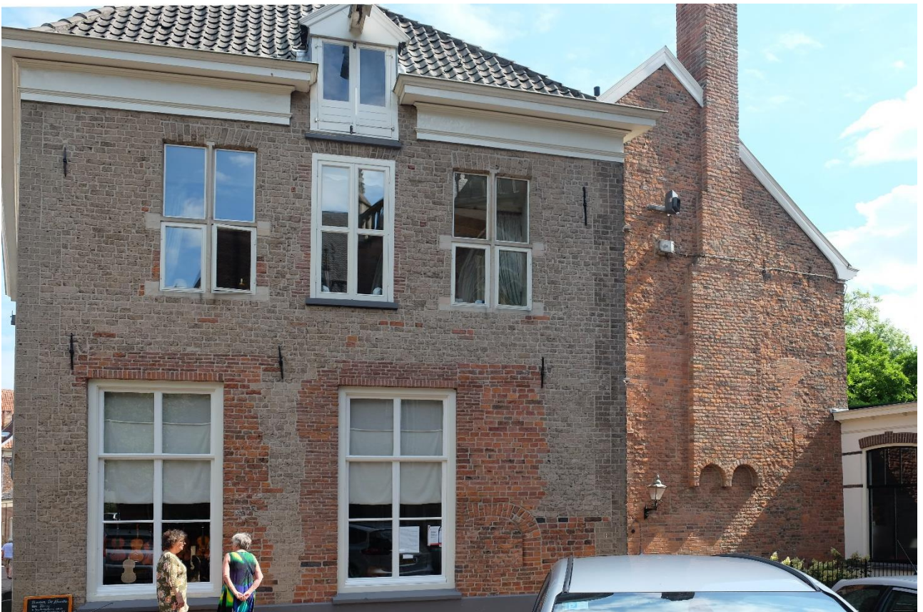
Woonhuis Kerkhof 34 in Zutphen, 19 augustus 2020 (foto Martin Tenpierik).
