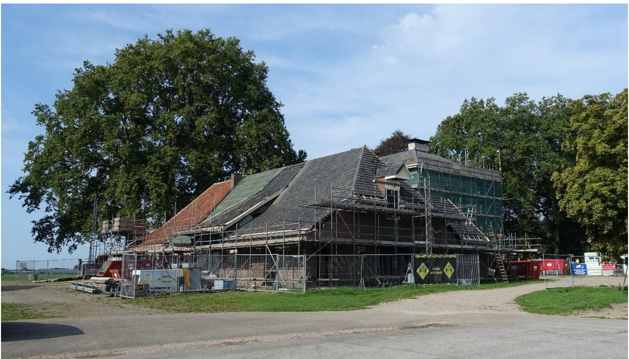
Reuversweerd verder in de steigers, 13 september 2020.
