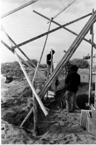
Fig. 7. Graduation project part of the building Hospedería del Banquete, 1973, Ciudad Abierta.
