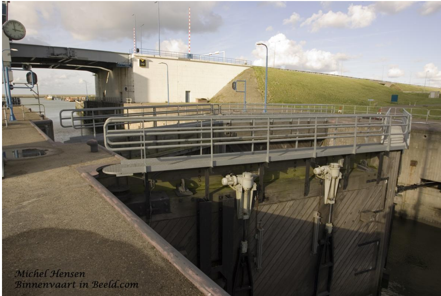
Figure 15: one of the gates in Goereese Sluis ( Goereese sluis | Binnenvaart in Beeld ).
