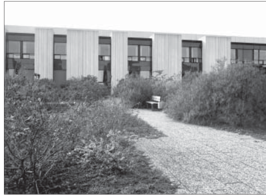
Documentation - Roof terrace in front of ward facade - Hovedstaden, Foreningen til Hovedsædens Forsønnelse 1978
