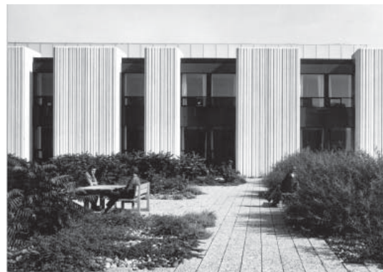
Documentation - Concrete ward facade: - Arkitektur DK, 1975, nr 8 Another similar view - but then in colour - is to be found in: - Natur og Miljø, nr 1, januar 1979
