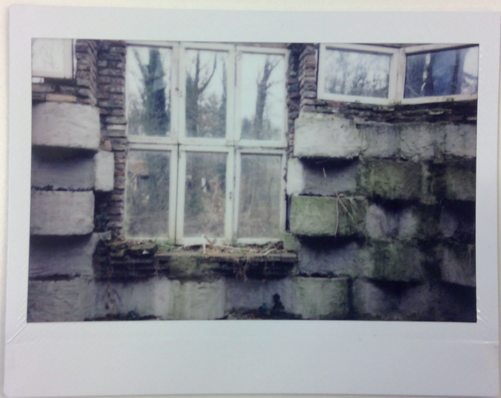
voorgevel vanaf de binnenkant
