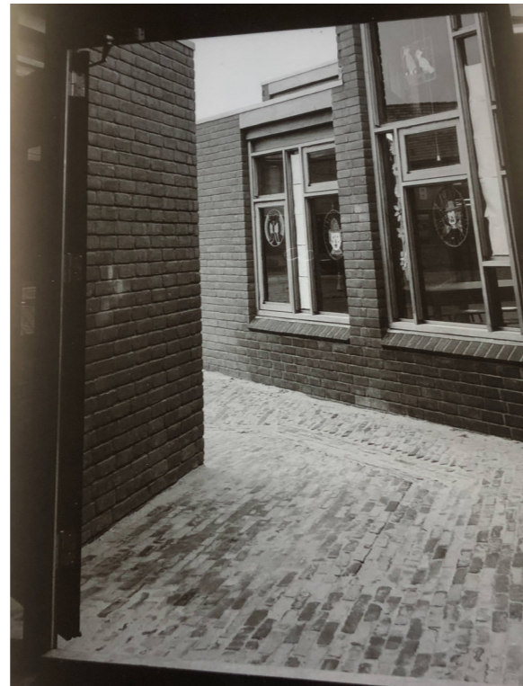
Fig.11. Het Nieuwe Instituut, Entrance Cuijk from inside.
