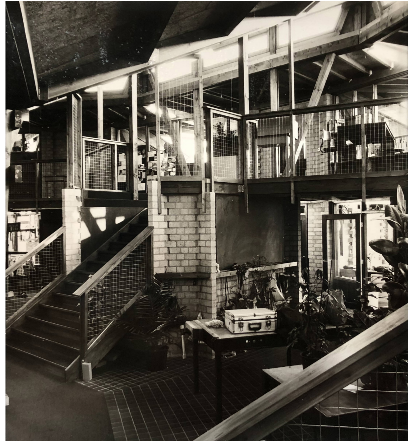
Fig.21. Het Nieuwe Instituut, Stairs and balconies common hall Leusden .
