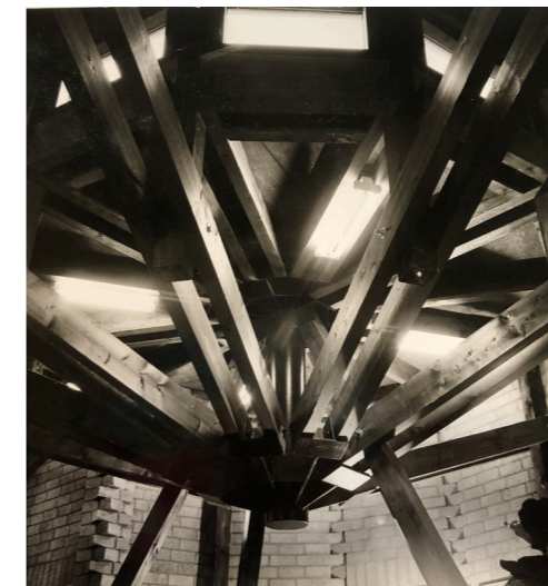
Fig.26. Het Nieuwe Instituut, Knot roof construction common hall Leusden.
