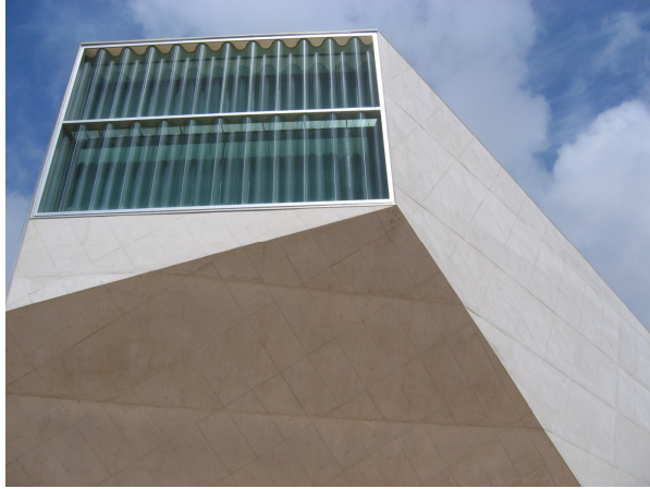
Figure 6. Façade Casa da Musica, Porto, Portugal
