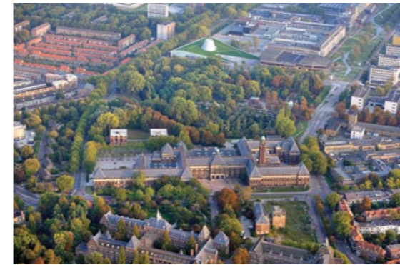
Figuur 1: Gebouw BK city, TU Delft, gefotografeerd vanuit het Noorden, met een deel van de campus – waaronder de centrale bibliotheek – op de achtergrond. Foto: Rob 't Hart voor TU Delft (2009)
