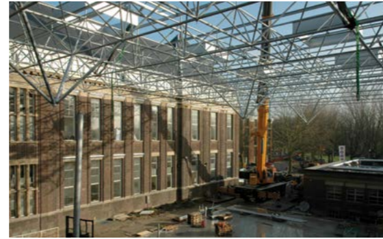
Figuur 13: De twee serres zijn bijna geheel reversibel toegevoegd om functies te huisvesten die niet in het oorspronkelijke gebouw onder te brengen waren. Foto: Wido Quist (2008)
