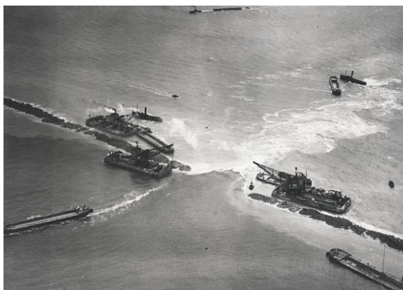
Figure 1.1: Final closure works: Afsluitdijk (Beeldbank Rijkswaterstaat, 2018)
