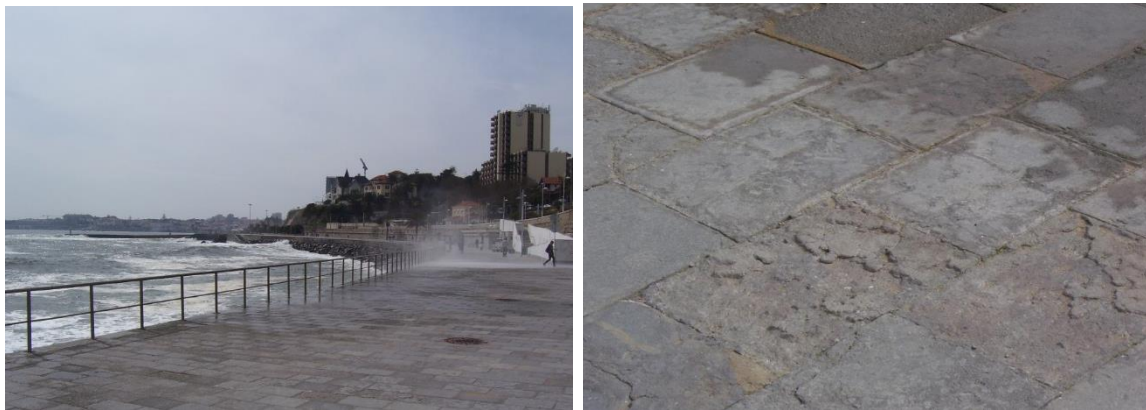
Fig. 10. Achteruitgang van een paar jaar oude kalksteentegels op de esplanade in Cascais waar regelmatig de golven over heen slaan (2010).
