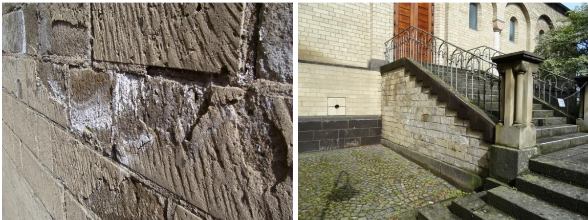
Fig. 7 (vervolg). Voorbeelden van zoutschade. Bovenste rij: zoutschade aan pleister, Suur-Klooster, Tallinn (2005). Onderste rij: Afspringen van Weiberner tuf, St. Maria im Kapitol, Keulen (2009 & 2017).
