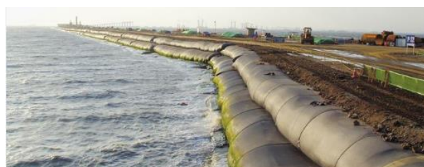
Figuur 6-8: Voorbeeld toepassing Geotube: Beschermingsdijk (TenCate Geosynthetics, 2020).
