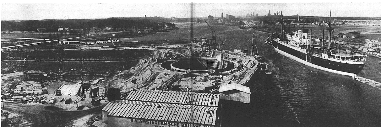
Figuur A-2: Het schiereiland aan de zuidoever met links de zuidelijke bouwput, in het midden de bouwkuip met aan de rechterkant de eerste kistdam (Rijkswaterstaat, 1957).
