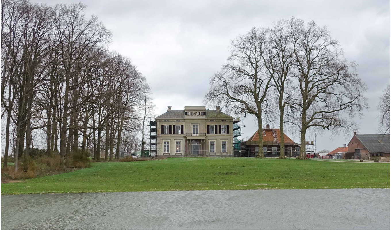
AFB. 1.10 Landgoed Reuversweerd in 2021 tijdens de restauratie aan het eind van het KaDEr-project (Hielkje Zijlstra).
