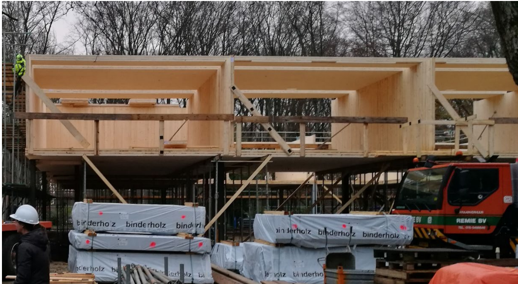
Figuur 2. Montage CLT bij het paviljoen op Landgoed Eikenburg. Foto: FAAM architects
