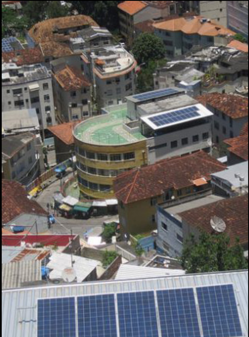
Painéis solares em prédios públicos Solar panels in public buildings CEPAC - Santa Marta, Rio de Janeiro, Brasil
