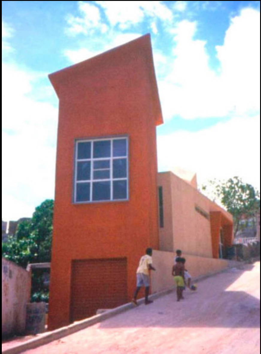
POUSO Office for Urban and Social guidance Posto de Orientação Urbanística e Social, Fubá, Rio de Janeiro, Brasil
