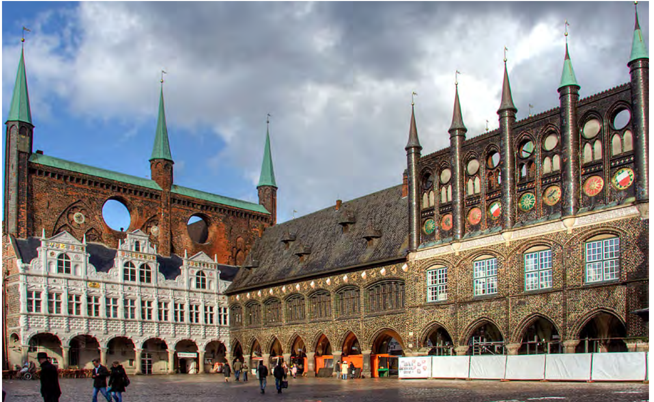
Noordgevel van Stadhuis van Lübeck, met ander bouwdeel van het stadhuis (Uli, 2008).
