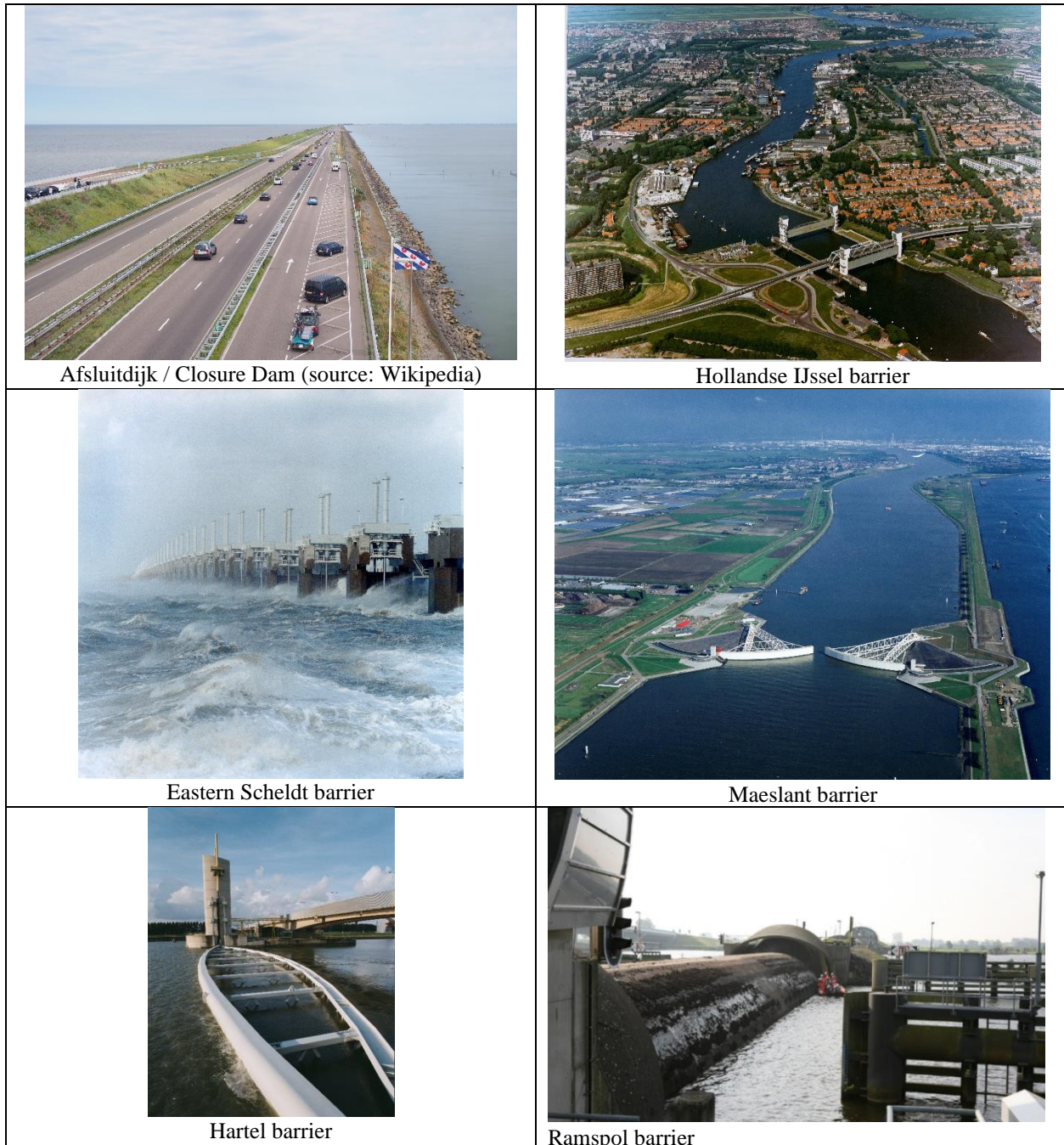
Figure 42: Images of the Dutch storm surge barriers. All images from Beeldbank (Photo Archive) Rijkswaterstaat. Source: https://beeldbank.rws.nl
