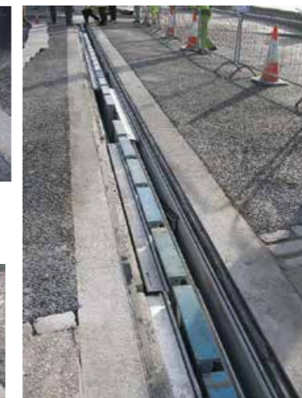
met eenvoudig gereedschap kunnen de panelen uit de goot worden getild, de schoren worden direct in de werkstand geplaatst
