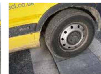
hier is gekozen voor een draagvermogen van de dekplaten van 150 kN/20x20 cms [x1,5]
