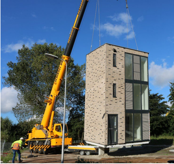
Figuur 6. De Roots van Startblock kan in 1 dag worden geplaatst
