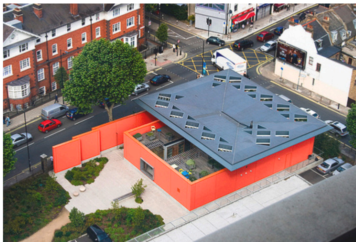
Plaatsing van het element in zijn context.
