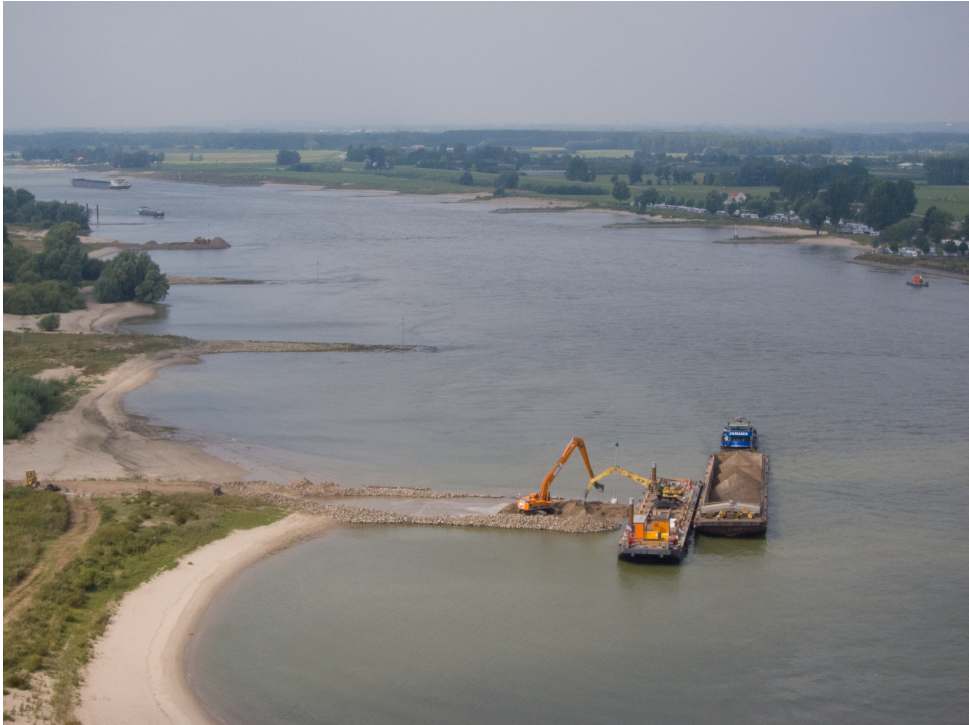
Figure 1: Lowering the groynes in the River Waal. Source: https://beeldbank.rws.nl , Rijkswaterstaat, Ruimte voor de Rivier.
