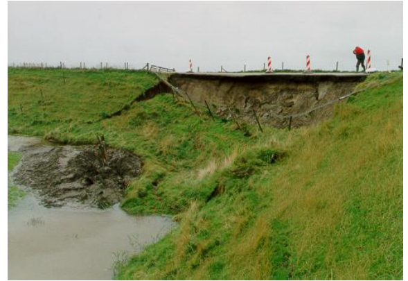
Figure 2-1 : Inner slope instability (Zwanenburg, van Duinen, & Rozing, 2013)
