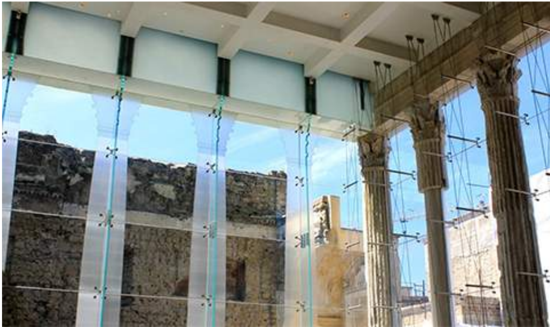
Fig. 4.12: Glass facade and column representation at Tempio di Augusto di Pozzuoli , IT (Enrico Colosimo, 2019)
