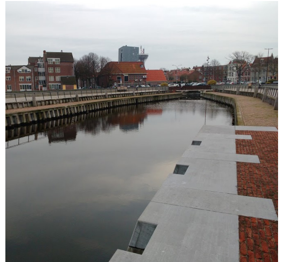
Vlissingen. Site visit
