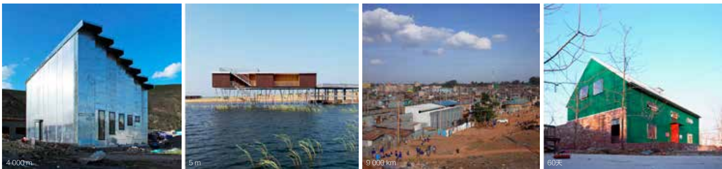
3 新芽体系衍生多维度的适应性(高海拔、潮汐水位变化、运达距离、快速建造等)
