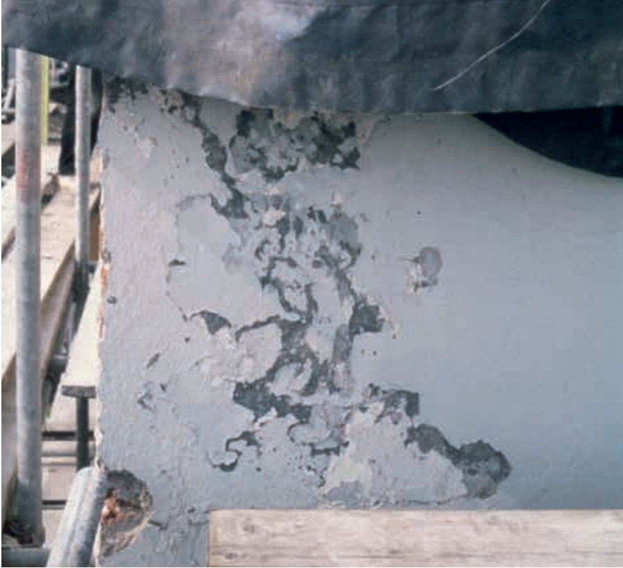
9. Op verschillende plekken, zoals hier op de schoorsteen, trof Bertus Mulder nog diverse resten stuc en afwerkklagen aan (Bertus Mulder archief)
