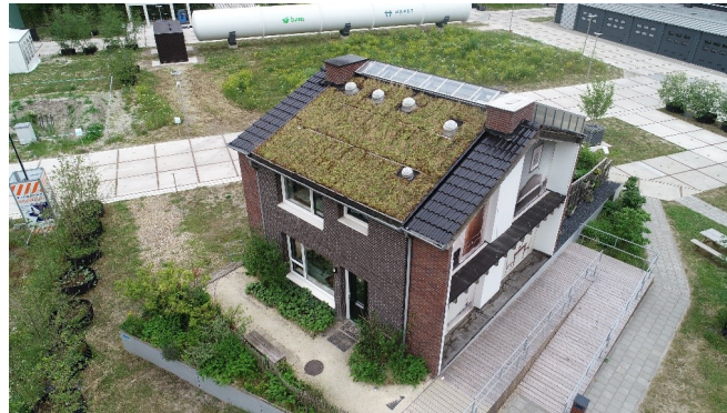
Figure 5.9: PRÊT-À-LOGER in Green Village, TU Delft.
