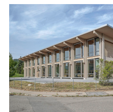
Ausbildungszentrum Holzbau Architect: Peter Moor Zürich, Switzerland GFA: 2,618 sqm
