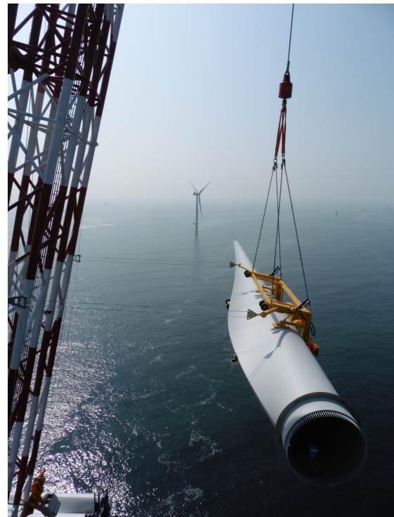
(d) Lifting blade to hub height
