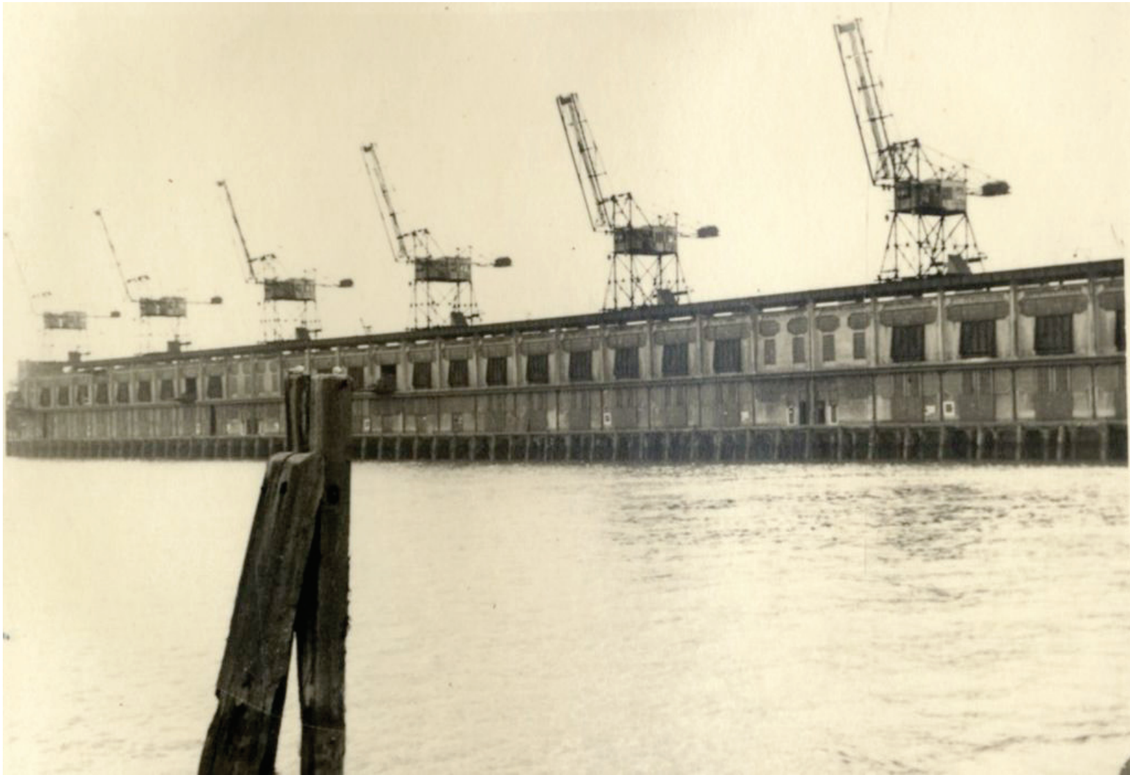
zicht op de San Francisco loods vanaf de Rijnhaven omstreeks 1943
