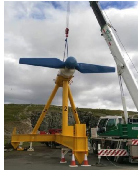
Fig. 1. Nova M100 tidal turbine.
