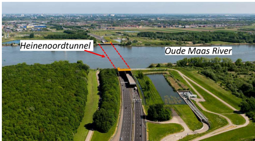
Figure 4.17: The Heinenoordtunnel under Oude Maas River (Rijkswaterstaat, 2022)
