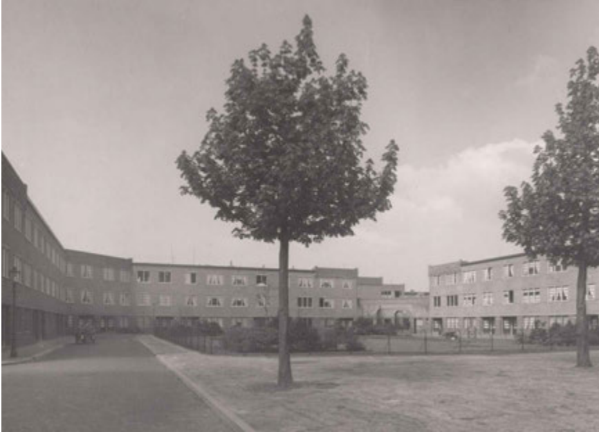
FIG. 3 Het Weigeliaplein, enkele jaren na de voltooiing, waarbij het tuinstadconcept tot een kleinstedelijk bebouwingsbeeld leidde [Gemeentearchief Den Haag]
