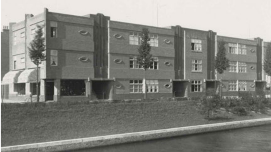
FIG. 8 Portiekwoningen aan de Valkenboskade 264–304 uit 1923, naar een ontwerp van Jacobus Barend Fels. Opmerkelijke elementen zijn de liggende, ellipsvormige ramen. Dergelijke ‘vormenwellust’ werd in de tweede helft van de jaren twintig verbannen door de bloei van de rechte lijnigheid van de Nieuwe Haagse School [Gemeentearchief Den Haag]
