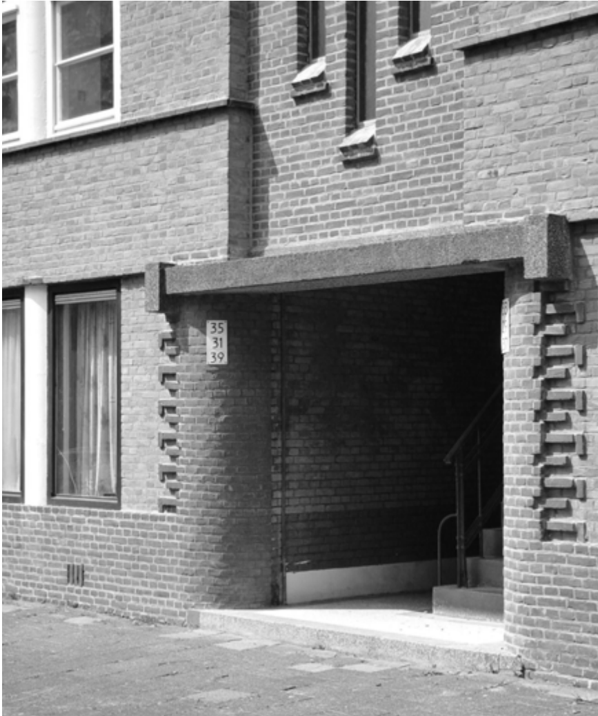
FIG. 9 Portiekentree, als onderdeel van een strook portiekwoningen uit 1924 van architect J. B. Fels aan de Mient 1-111. Het roodkleurig metselwerk van de plint is ter hoogte van de entrees verticaal doorgezet en rond gemetseld [foto Marcel Teunissen, 2003]
