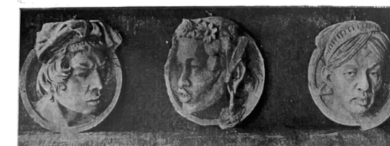
Gevel Hoofdingang. „Karakterkoppen”
