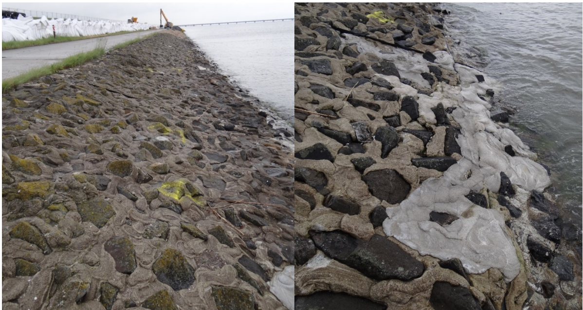
Abbildung 26: Deckwerk am Voslapper Groden (Fotos: Kreyenschulte 2016).
