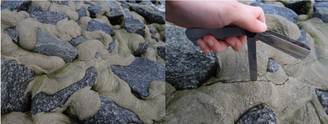
Abbildung 3: Risse des Typs 2 (Fotos: Kreyenschulte 2015).
