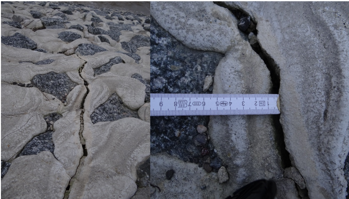
Abbildung 4: Risse des Typs 3 (Fotos: Kreyenschulte 2015).
