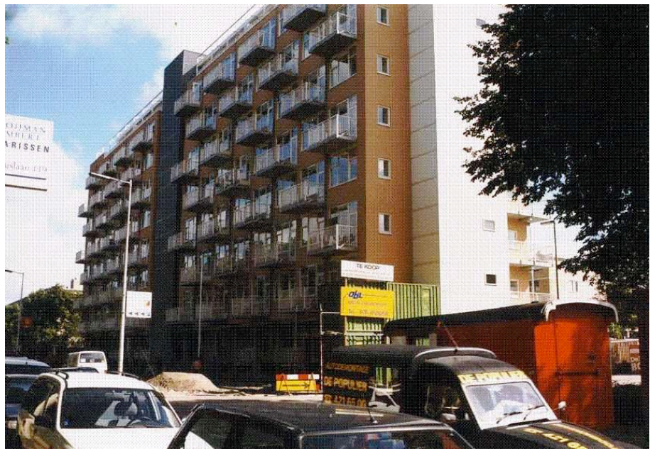
Fig. 2.5 Naar woningen getransformeerd kantoorpand aan de Koning slaan in Rotterdam
