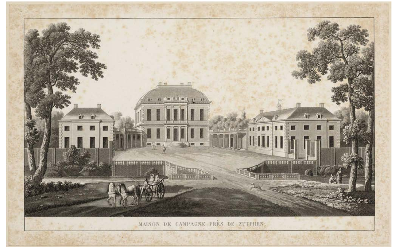
MAISON DE CAMPAGNE PRÈS DE ZUTPHEN. NO DATE. GELDERLAND IN BEELD, GDC007000043.
