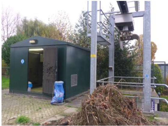
Figuur 2.6: Gemaal Plukmade op 20-11-2018
