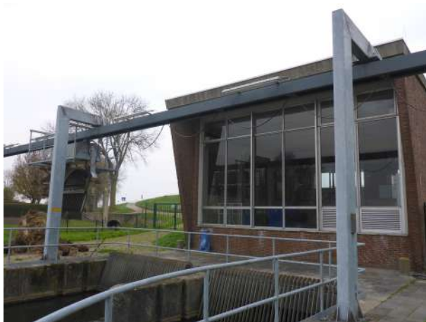
Figuur 2.8: Gemaal Tonnekreek op 20-11-2018
