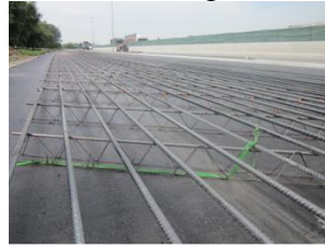
Figuur 2. Wapening van de DGB-verharding in een proefvak op de E17 bij Gent.
