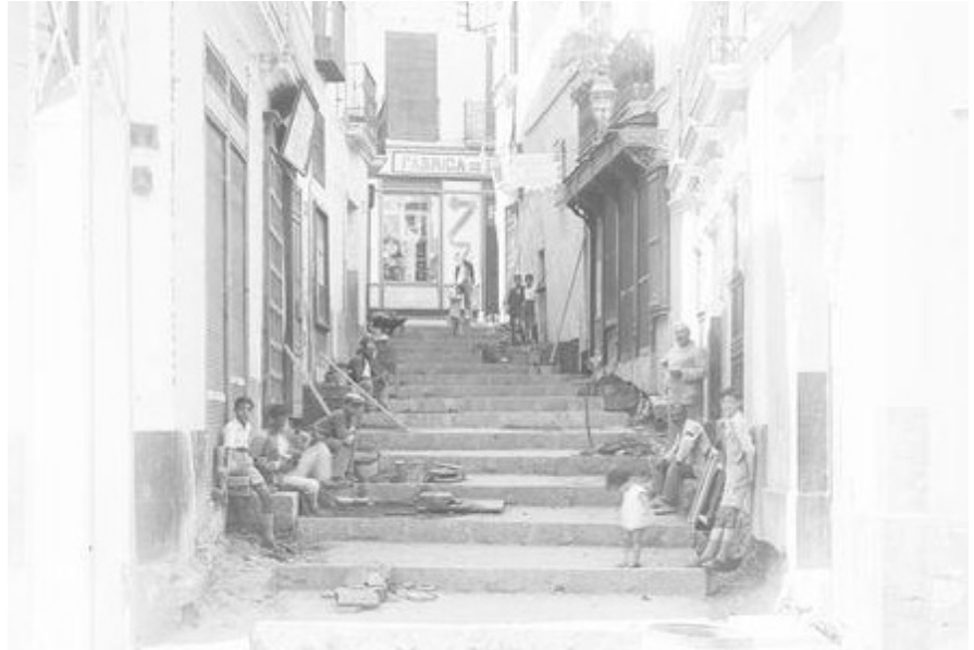
Figure 14. Paving of the slope of Luján in 1927. Retrieved from the Archivo Municipal de Córdoba.
