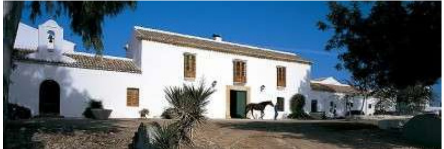
Figure 7. Exterior facade of Cortijo de Don Pedro (Junta de Andalucía, 2001).
