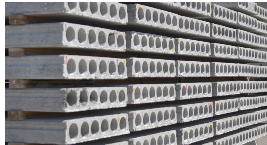
(d) Hollow core slab.
