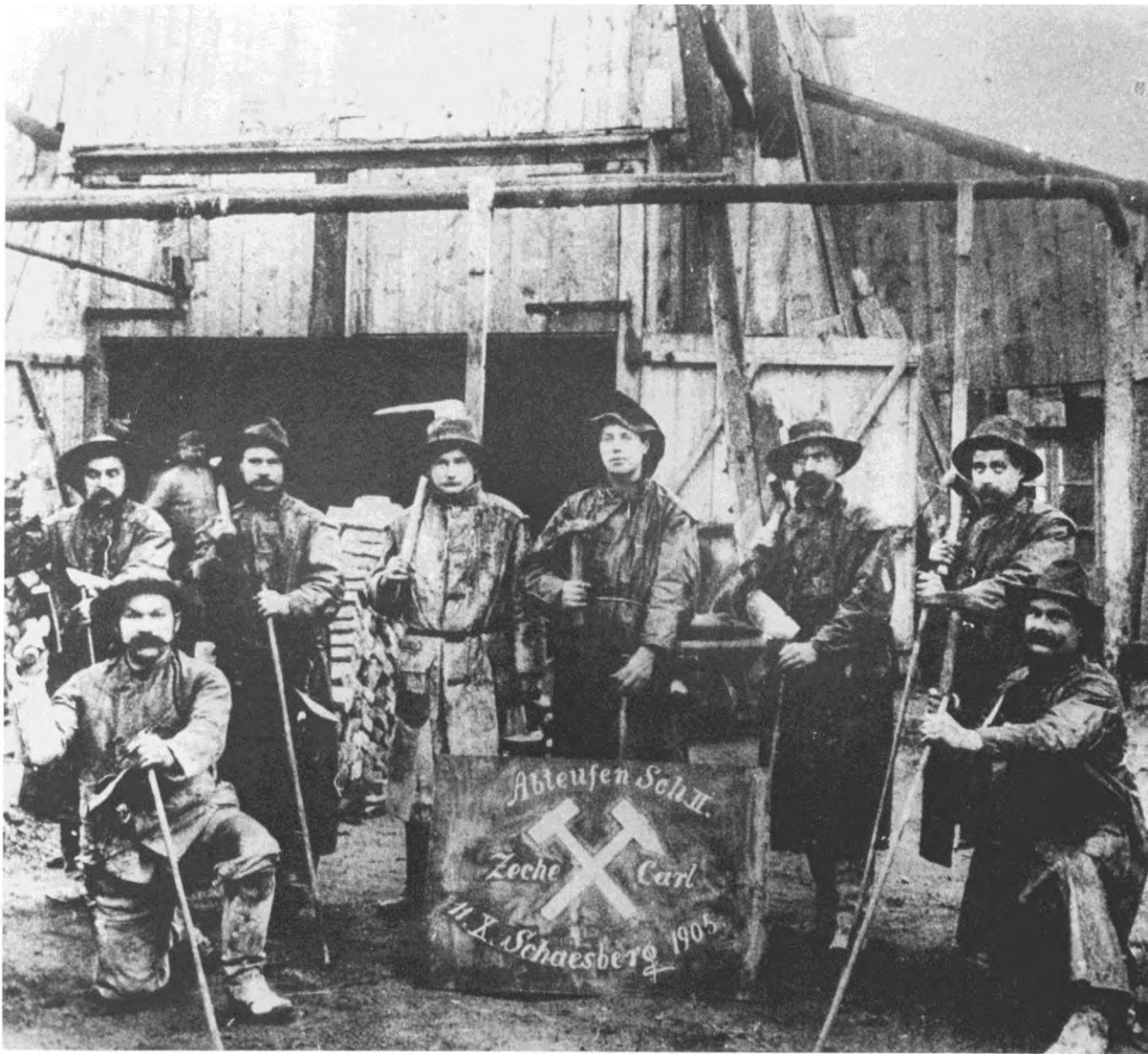
Aanleg Schacht II van de mijn "Carl", de latere ON-II, 11 oktober 1905.
