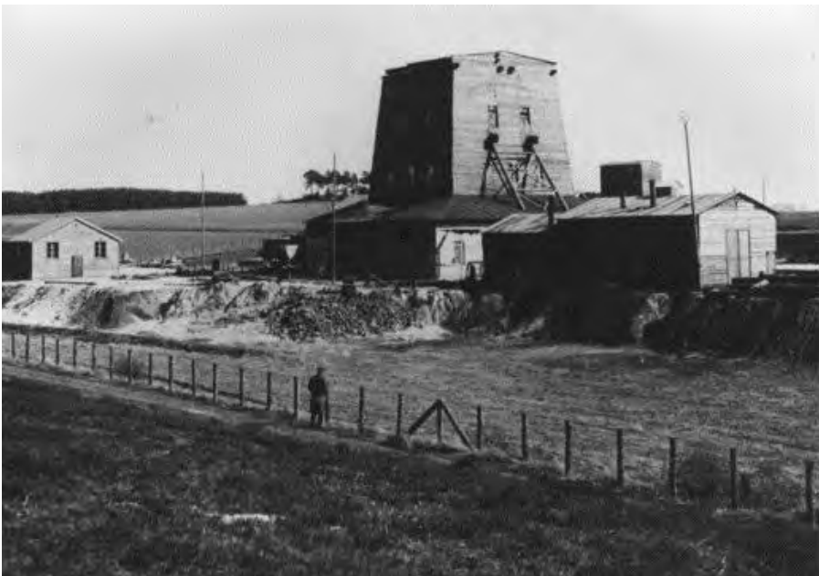
Afdieptoren van de mijn ON-IV tijdens de schachtaanleg rond 1910. Fotocollectie D. Visser
