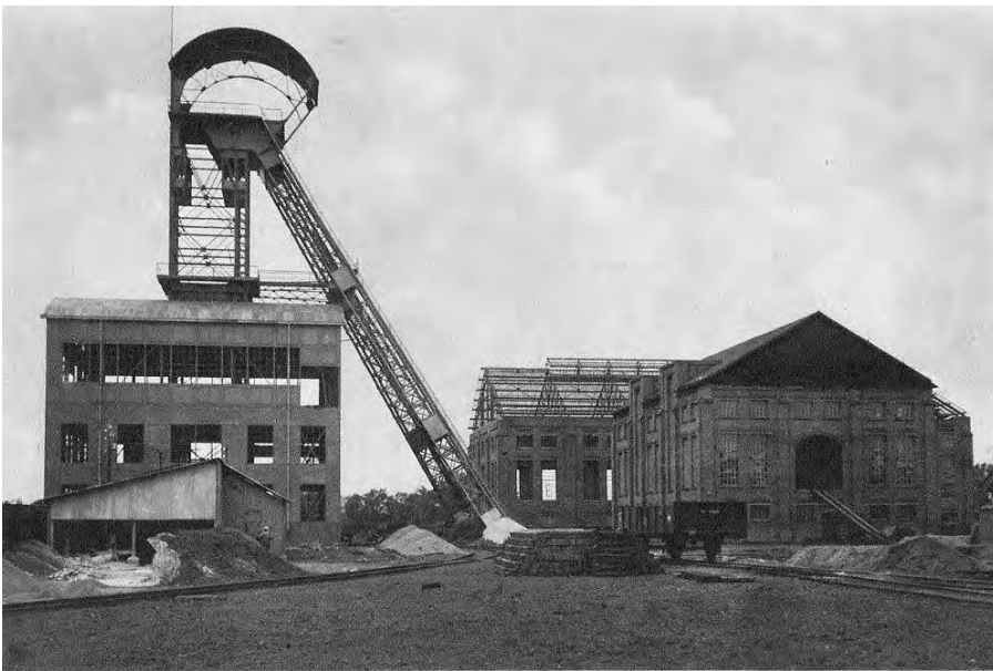
De ON-III in aanleg, rond 1914.
