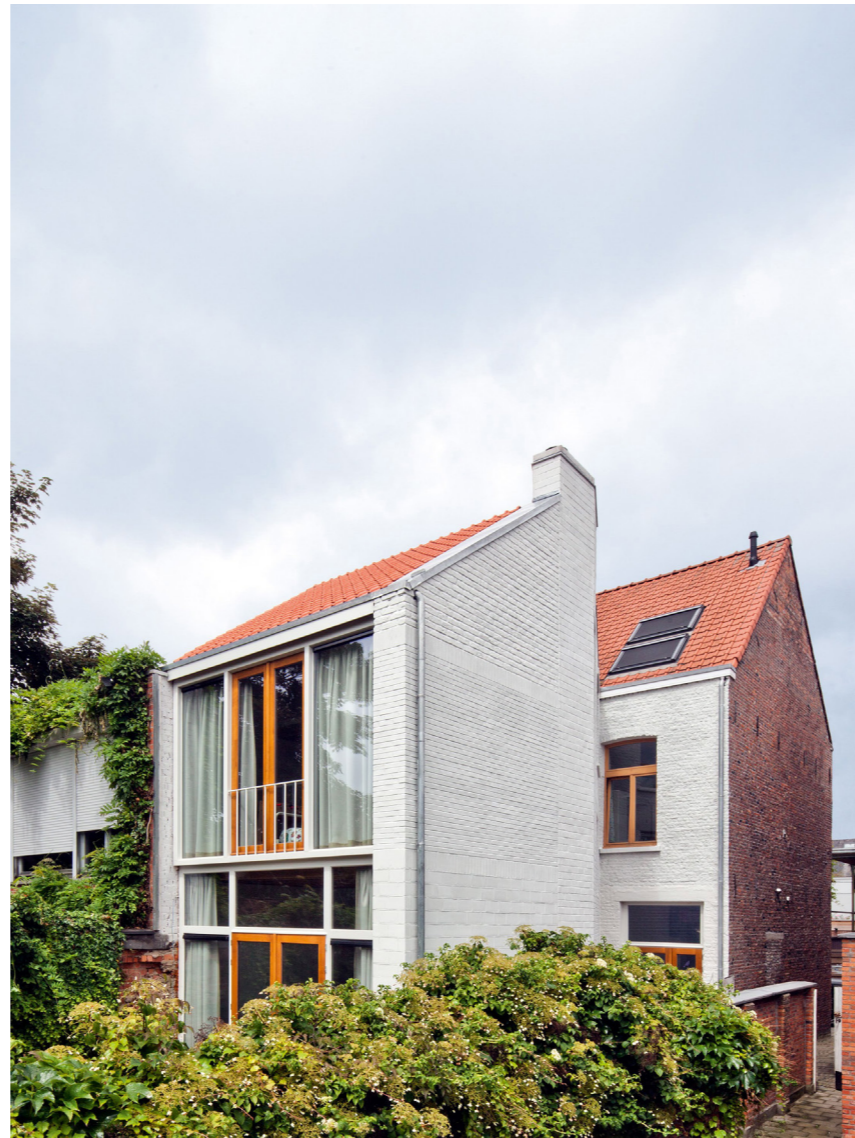
House extension Mortsel Bovenbouw
