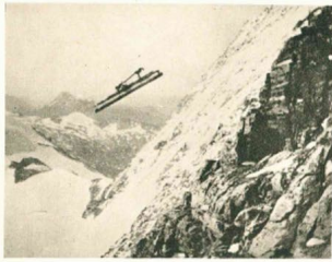
Ascension des poutres.
