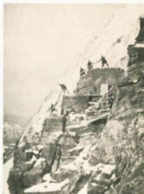
Empilage des bois au point III.
