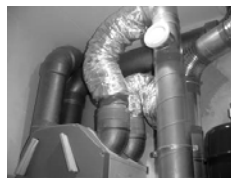
Afbeelding 2 (Installatie voor balansventilatie)
