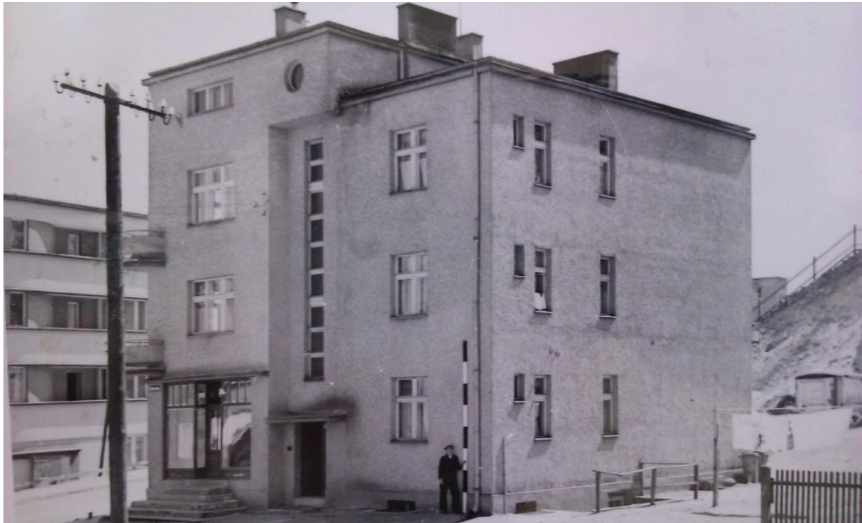
Figure 10. Revenue house on Słupecka 11, Circa 1940, Source: Gdyński Szlak Modernizmu, “modernizmgdyni.pl”, n.d. https://modernizmgdyni.pl/?p=1541
