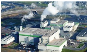
Ecluse (Bron: ecluse.be)
