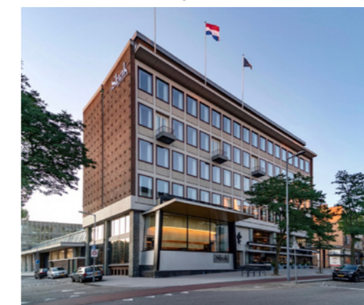
Figure 1: Slaakhuys building after the transformation by Mei architects, Rotterdam, NL. https://www.rotterdamarchitectuurprijs.nl/media/images/thumb_constrain_1136_1136/schermafbeelding-2019-10-03-om-083301.jpg
